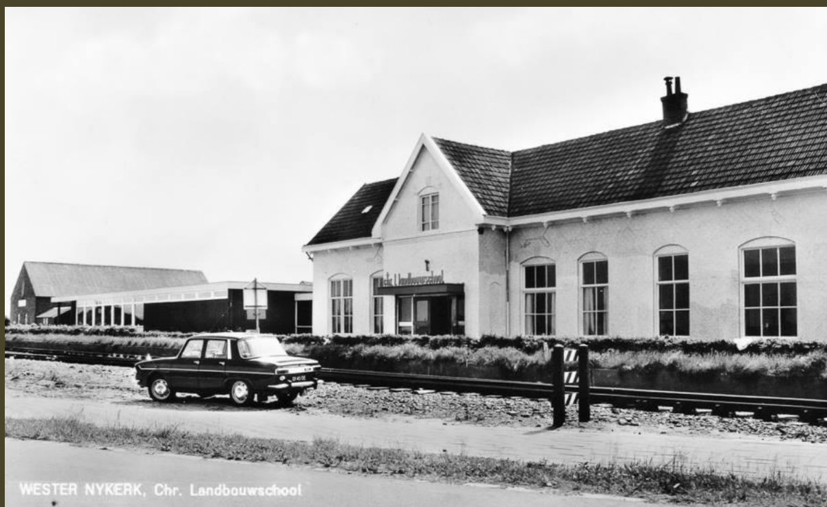
Het voormalig station in gebruik als Landbouwschool
